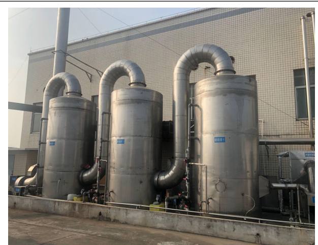
树脂车间废气处理装置
